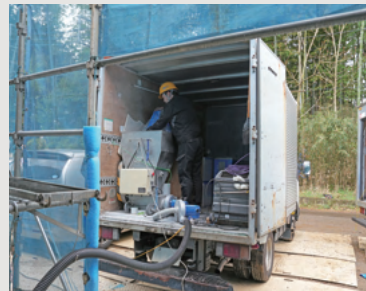
専用の機械を使って断熱材を送り込む。
