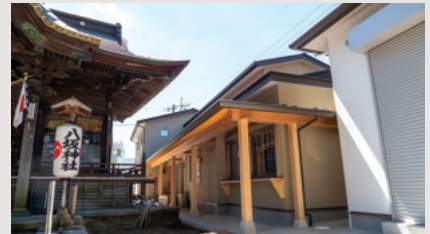
佐藤棟梁と采女棟梁が担当した八坂神社様の神輿蔵と社務所は8月末に完成。地元のために頑張りました！
