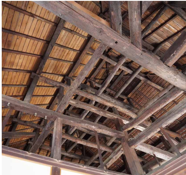
むき出しになった天井裏を見上げる。屋根を支える複雑な構造は圧巻。
