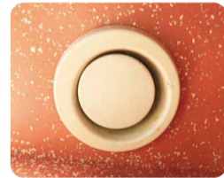
左2枚/排気口はトイレやクローゼットの天井に取り付けられており汚れた空気や湿気を排出しています。右/排気口のホコリを掃除機で吸い取ります。
