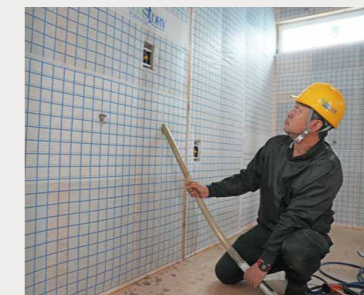
隙間なく吹き込むには高度な技術が必要。
