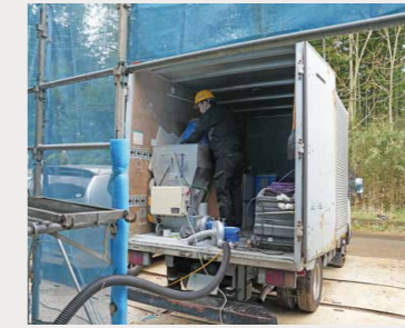
専用の機械を使って断熱材を送り込む。
