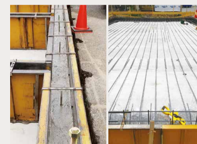
■ 綺麗に並んだアンカーボルトが丁寧な仕事の証。
