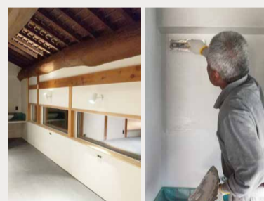
古民家をリノベしたMUNIの壁も仕上げた。
