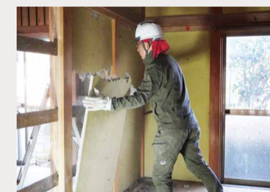
丁寧かつ効率よく作業を進めます。
