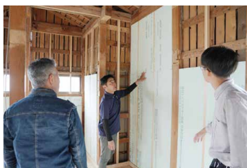
断熱材を入れ、下地材で強化します。
